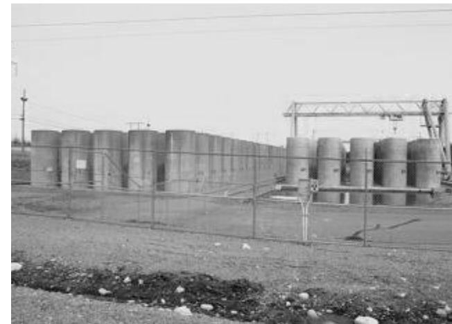
Silos en béton vieillissants contenant des déchets radioactifs mortels dits « de haute activité » produits par le réacteur nucléaire de Point Lepreau, dans la baie de Fundy. Photo: CSSN.
